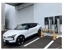
超急速EV充電器「Hypercharger」〈パワーエックス社製〉 358kWhの蓄電池と超急速充電器2基を組合せた製品で、 最大150kWでのEV充電が可能
